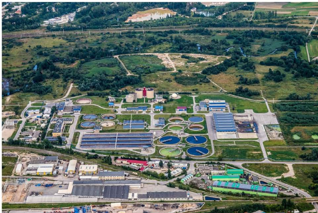
Planta de tratamiento de agua
