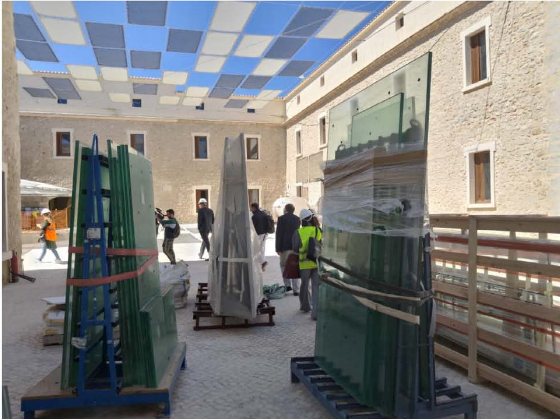
Obras del Parador de Ibiza.
