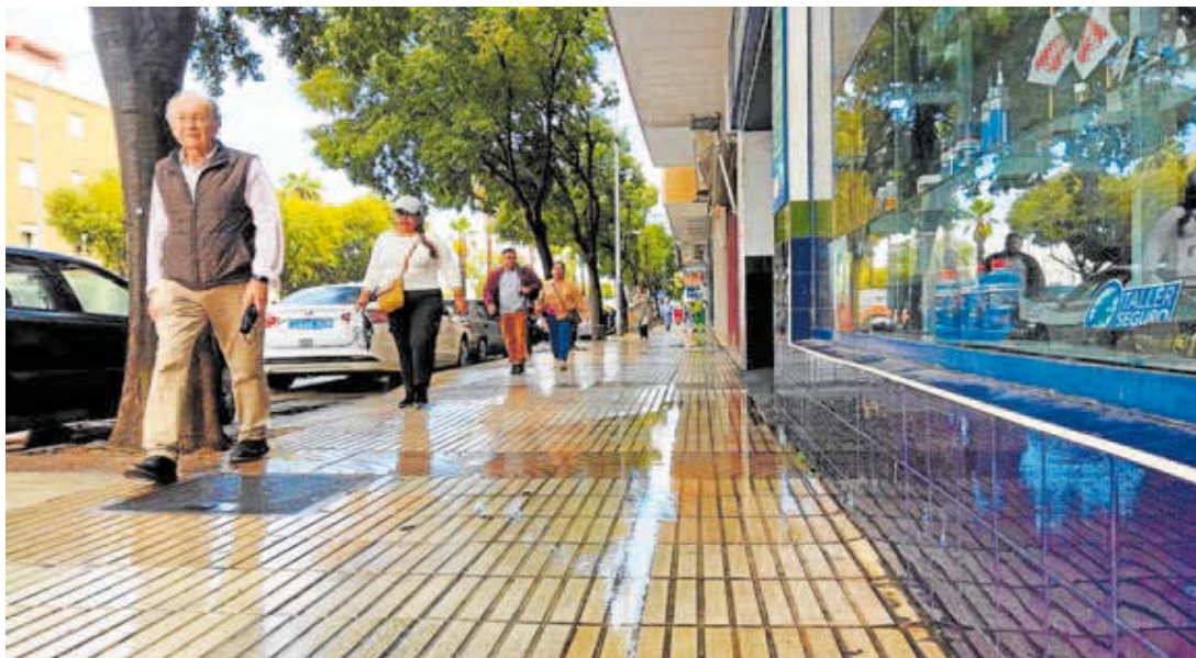
Cuando llueve, los vecinos tienen que caminar en fila india para no pisar los charcos. HOY
